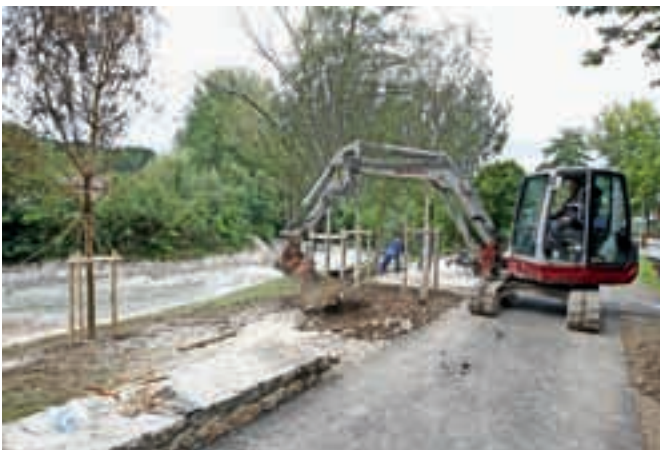
Območje Podna je po izvedenih poplavnih ukrepih sedaj poplavno varno.
