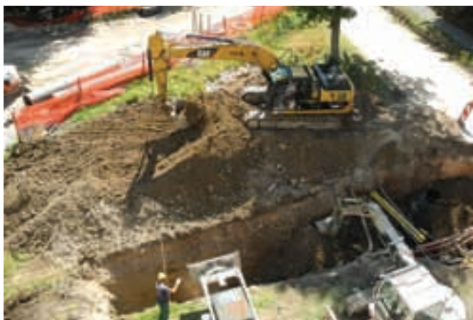
Med gradnjo kanalizacije.
