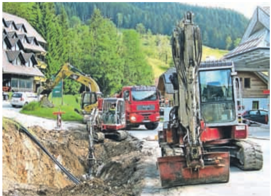
Na Jezerskem so gradili novo kanalizacijo s čistilno napravo.
