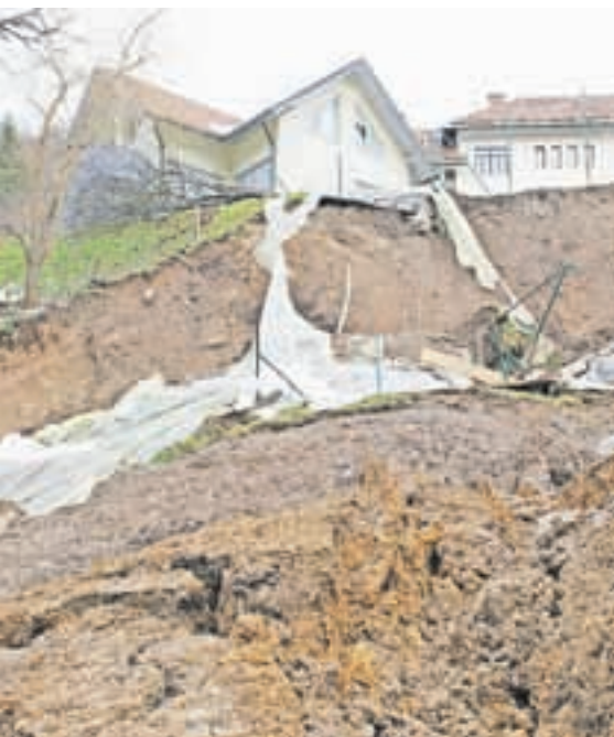
Zemeljski plaz na Sovodnju
