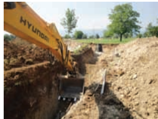
Kanalizacijo so gradili v Zabreznici in na Selu.
