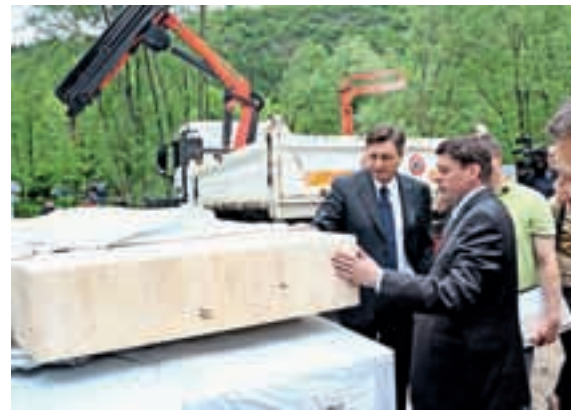
Borut Pahor si je ogledal gradbišče kolesarskega mostu v Bohinjski Bistrici.
