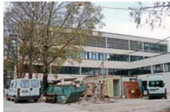
Obnova in gradnja prizidka OŠ Toma Brejca.
