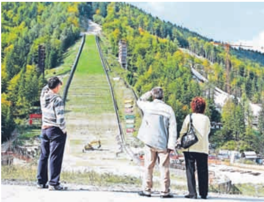
Obnova planiške velikanke se bo zavlekla v prihodnje leto.
