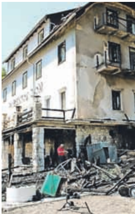
Požar je uničil Porentov dom v Kranjski Gori.
