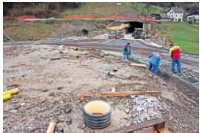
Najmanj so v Škofji Loki zadovoljni s potekom del na poljanski obvoznici, saj se zaradi zapletov pri razpisih nikakor ne premakne gradnja druge in tretje faze.
