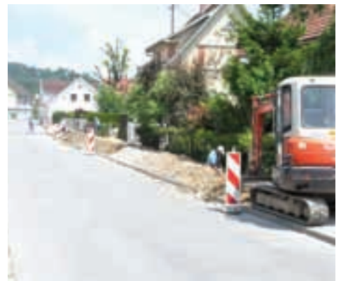
Gradnja optičnega omrežja
