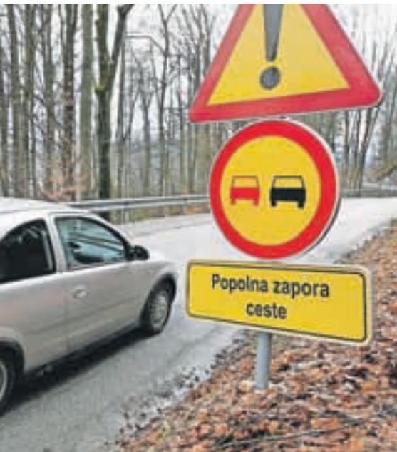
Začetek obnove ceste Radovljica-Lancovo
